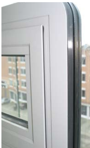
Buiten- en binnenaanzicht van de te openen raampjes die zijn geïntegreerd in de grote glasvlakken; de verticale lijnen zijn reflecties van de glaslamellen.
