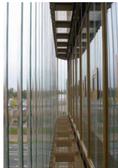
De dubbele gevel met links de gebogen glaslamellen en rechts de pui met geïntegreerde raampjes. Foto: Rik Vollebregt
