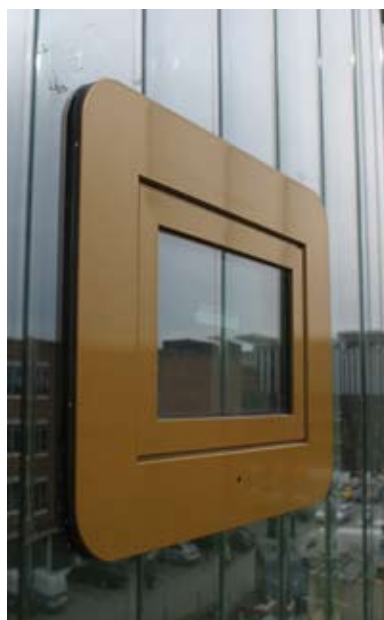
Buiten- en binnenaanzicht van de te openen raampjes die zijn geïntegreerd in de grote glasvlakken; de verticale lijnen zijn reflecties van de glaslamellen.
