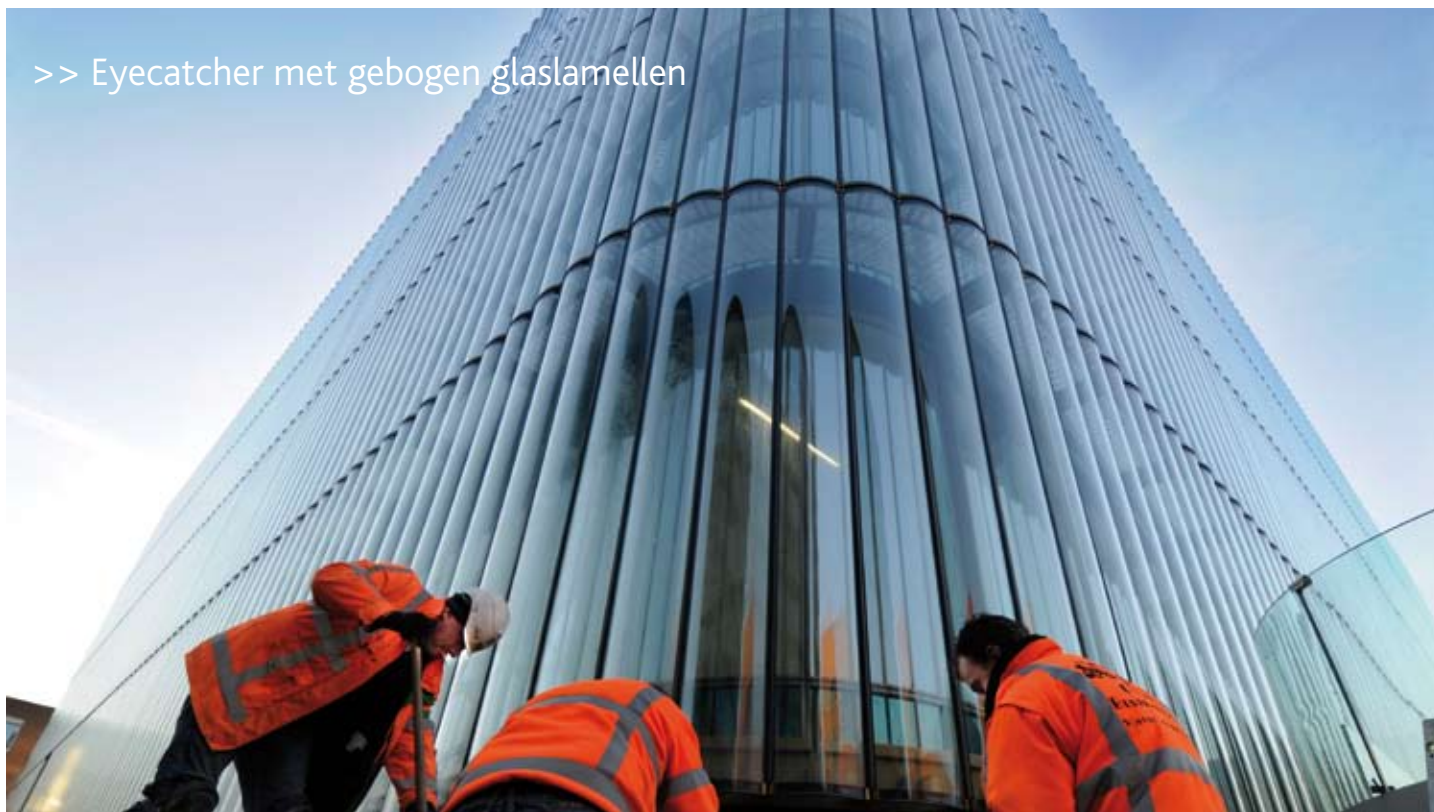
De afgeronde hoeken zijn karakteristiek voor het gebouw; ook de isolatieglasruit in de binnengevel is gebogen. Rechts het inmiddels aangebrachte gebogen glas voor de balustrade van de hellingbaan. Foto: Frans Andringa
