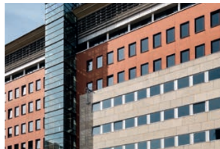
▲ Door het vacuümglas hybride uit te voeren konden de bestaande aluminium kozijnen inclusief glaslijsten behouden blijven.
