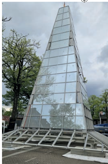
▲ Het glas is naast de kerk in een stalen constructie prefab gemonteerd en het geheel is in één keer op de toren geplaatst.
