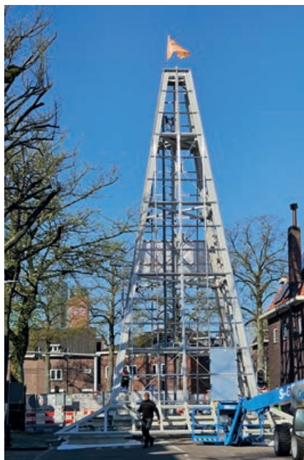
▲ Het glas is naast de kerk in een stalen constructie prefab gemonteerd en het geheel is in één keer op de toren geplaatst.
