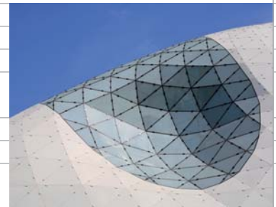
Bolle vormen blijven uit zichzelf relatief gemakkelijk overeind; maar bij de 'deuken' moet de constructie hoge krachten opnemen Foto: Rob Hoekstra
