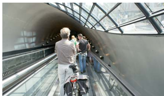
De toegang naar de fietsenkelders onder het plein heeft een kap met gebogen en gelamineerd glas. Foto: Fietsberaad
