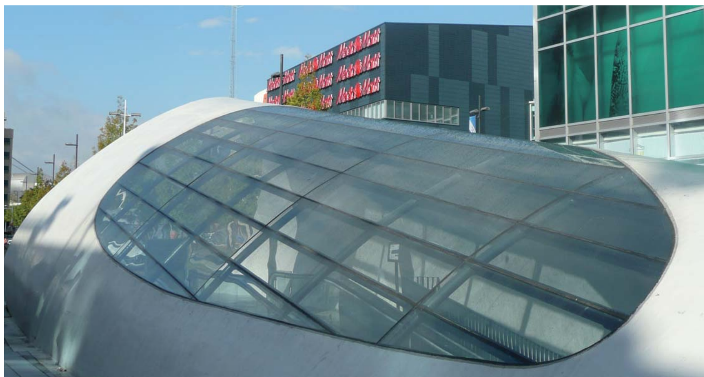
Het gebogen glas loopt naadloos over in het oppervlak van de kap. Foto: Rik Vollebregt
