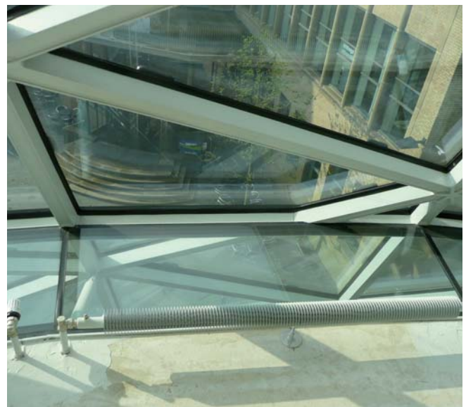
Een beloopbare glasstrook vormt de overgang tussen de betonnen vloer en de gevel. Foto: Rik Vollebregt
