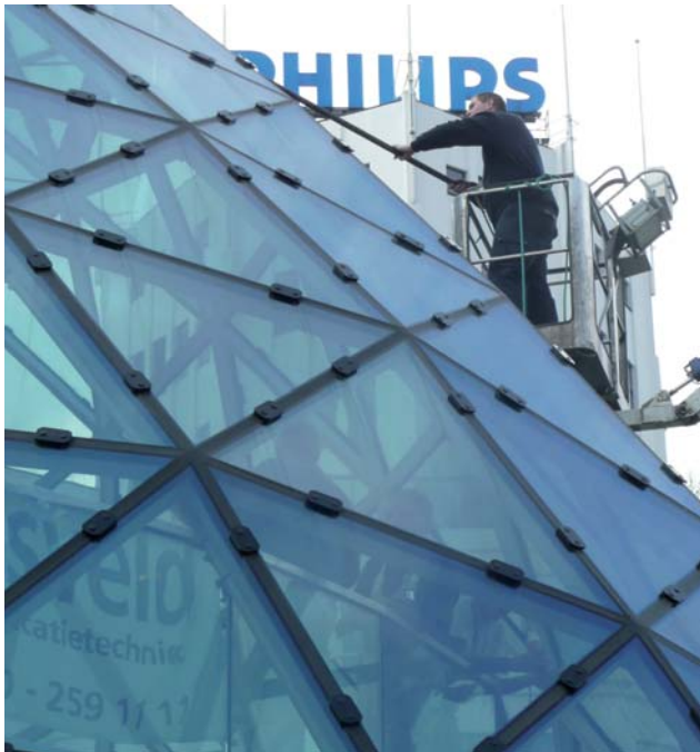
ledere twee maanden wordt de Blob vanuit een hoogwerker gewassen. Foto: Rik Vollebregt
