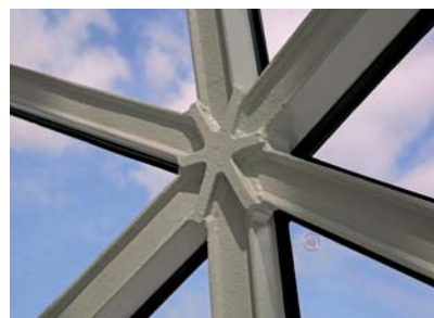
Vanwege de vorm van de gevel zijn alle knopen uniek. Foto: Rob Hoekstra
