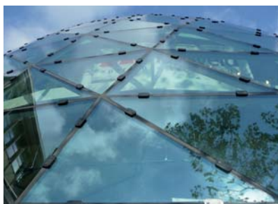
Het glas is aan de buitenzijde met aluminium plaatjes geborgd. Foto: Rik Vollebregt
