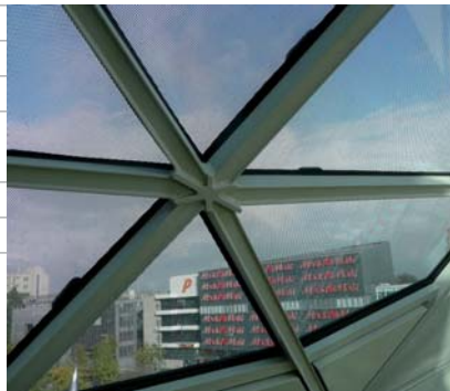
Een deel van de ruiten heeft een zeefdruk gekregen. Foto: Rik Vollebregt
