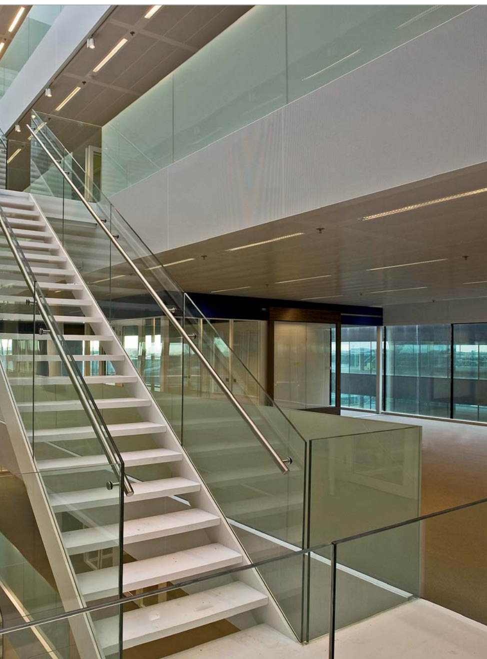
De glasbalustrades maken het interieur nog transparanter. Foto's: Sterkos / Fas Keuzenkamp
