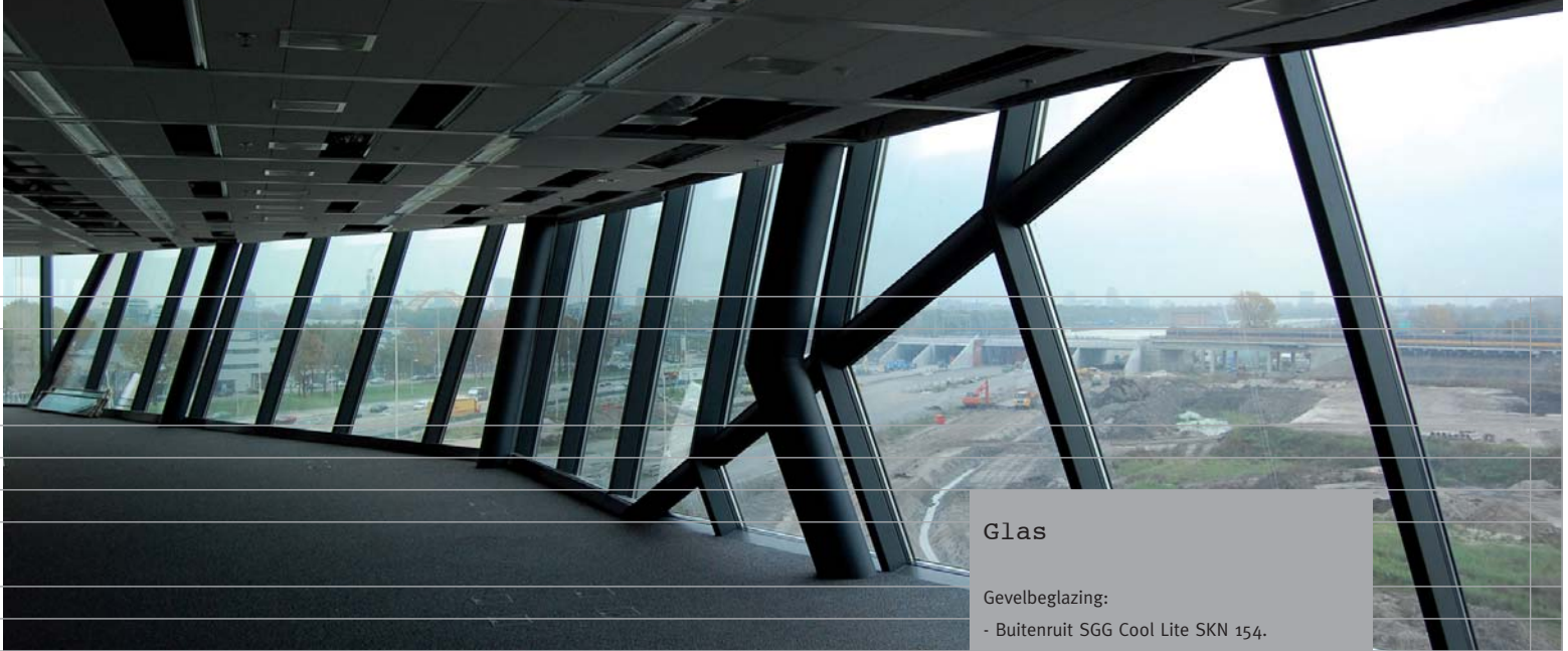
Uiteenlopende vormen en afmetingen van de beglazing op de raakpunten van de gevelvlakken. Foto: TIB
