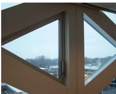
De kozijnen en maatvoering zijn zo uitgekend dat vaste ramen (rechts) en te openen ramen (links) omgewisseld kunnen worden; wat handig is bij het verplaatsen van binnenwanden. Foto: Rik Vollebregt
