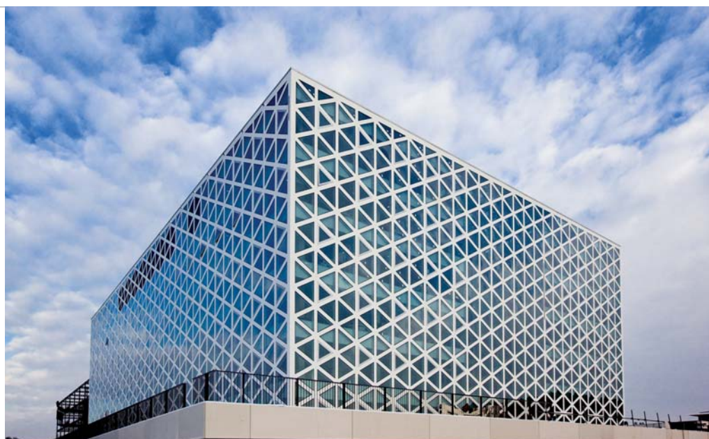
De gevel van gebouw X is helemaal vlak omdat de buitenzijden van het glas en die van de composietprofielen in hetzelfde vlak liggen. Foto: Holland Composites Industrials
