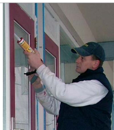
Bij veiligheidsglas moet worden gekozen voor een afdichtingskit, die het risico op aantasting van de folie zoveel mogelijk minimaliseert.
