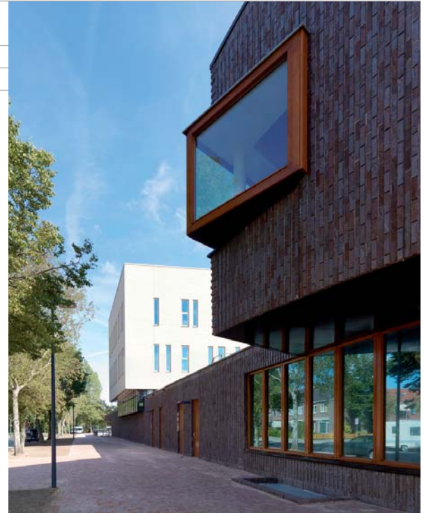
Op de verdieping van de bibliotheek is een forse horizontale glasstrook gemaakt.
