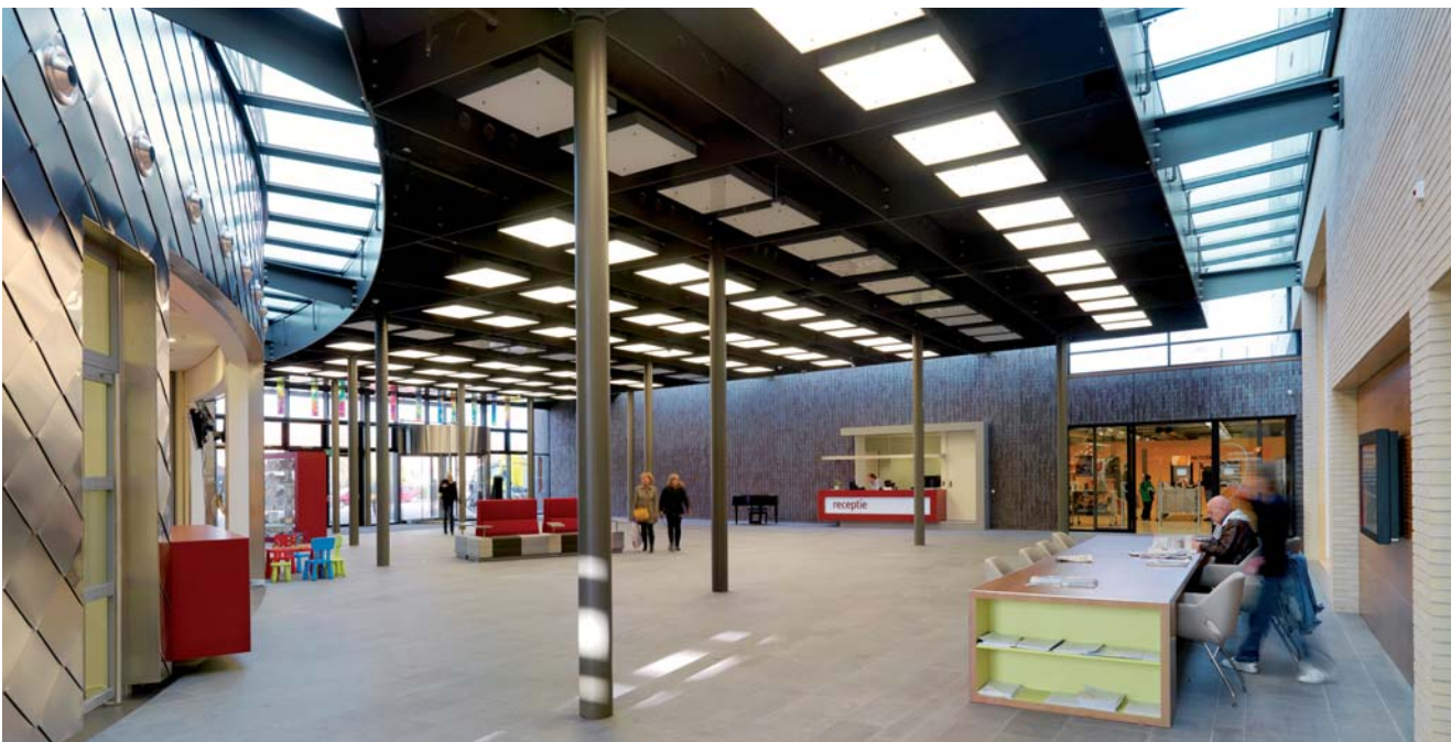
De lichtstraat brengt extra daglicht in de centrale hal en omdat de gevel doorloopt, ontstaat het idee van buiten te zijn.
