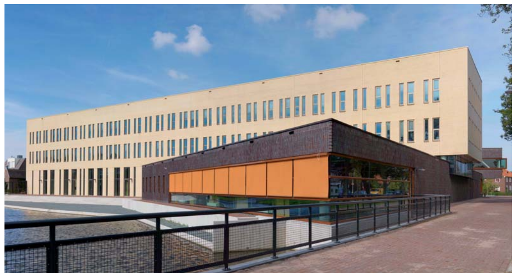
De gevelramen van het kantoorgedeelte zijn verticaal, zodat binnenwanden vrij verplaatsbaar zijn.
