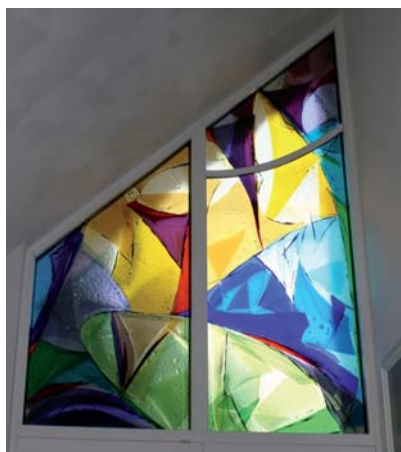
Voorbeeld van glasfusing in dubbelglas.
