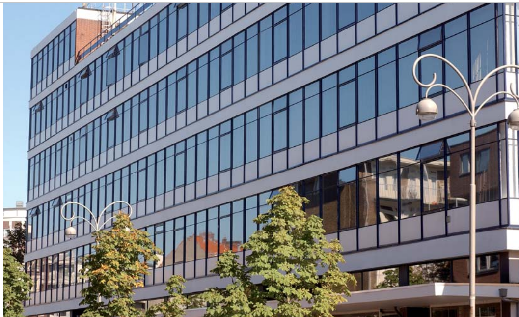
Toepassing van de Llumiar Enerlogic folie van Man Protection in opdracht van Corriander Real Estate, Amsterdam. Foto: Man Protection
