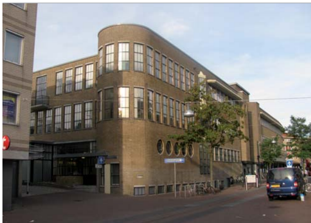
Comfortabel werken in het voormalige V&D-pand in Enschede door een Sterling folie die ruim 70 procent van de zonne-energie weert. Foto's: De Kock Glasfolies
