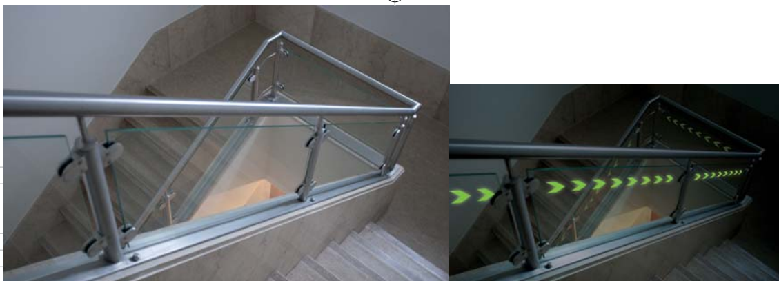
Het op de Glasstec gepresenteerde, Lumineo van Trosifol: 'luminescerende' folie voor het markeren van vluchtwegen zonder dat noodverlichting noodzakelijk is. Foto's: Trosifol
