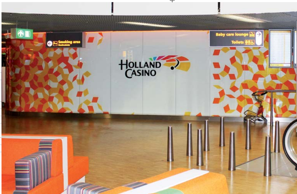
Pui van Holland Casino op Schiphol, voorzien van Clearfilm en deels Backlitfilm van Van Dijken Glas (10 mm gehard/gelaagd glas). Foto: Van Dijken Glas
