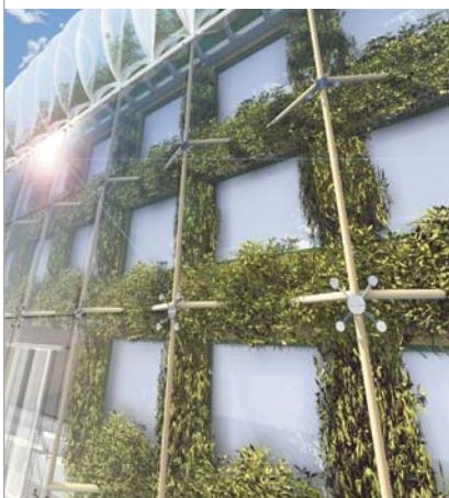
Detail van de kas op het dak van een schoolgebouw dat ervoor zorgt dat leerling en student les krijgen in een frisse omgeving.
