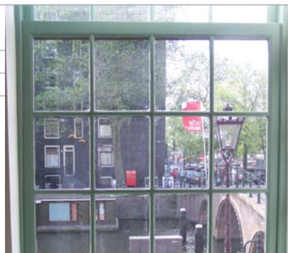
De schuiframen met kruisroeden zijn kenmerkend voor het gebouw. Foto: Rik Vollebregt
