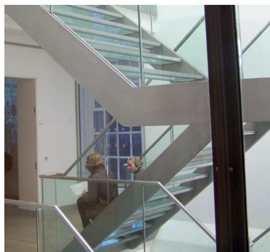
Dakramen, glazen traptreden en balustrades brengen ruimte en helderheid in de trappenhuizen. Foto: Rik Vollebregt
