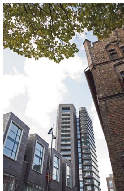
De Romertoren, ontworpen door architect Jo Coenen, is dé landmark van Venlo en onderdeel van de ontwikkeling van de Maasboulevard. Een woontoren van 65 meter hoog, met 18 woonlagen en moderne, lichte en zeer ruime appartementen. Scheuten Glas leverde 2100 vierkante meter Isolide Superplus voor deze moderne, strakke woontoren. Foto: Scheuten Glas
