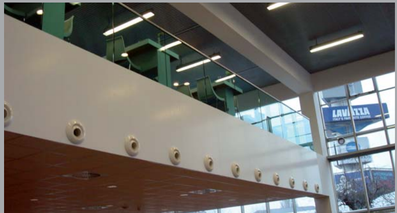
Glazen balustrade van Pol Balkonhekken uit Groningen, toegepast in de RAI in Amsterdam. Foto: Pol Balkonhekken
