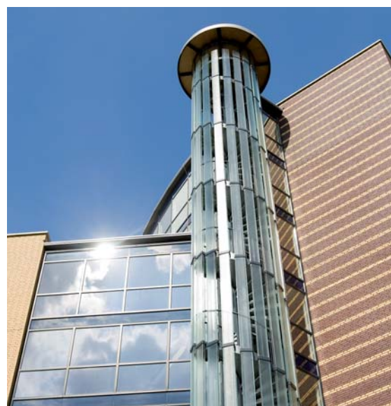
Trappenhuis met trapsgewijze 'ronde' toepassing van profielglas.
