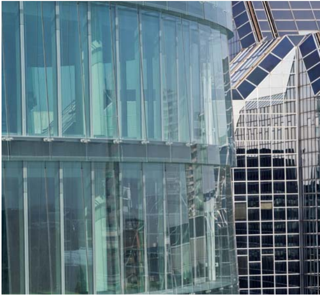
De tweede-huidgevel bestaat uit gepotdekselde glasplaten. Op de achtergrond de spiegelende gevel van het oude Rabobank-kantoor. Foto: Bertus de Ruiter
