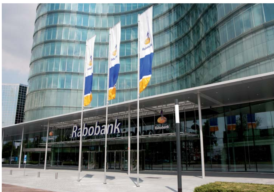
Aan de binnenzijde houden 7 meter hoge glasvinnen de entreepui op zijn plaats. Foto: Bertus de Ruiter
