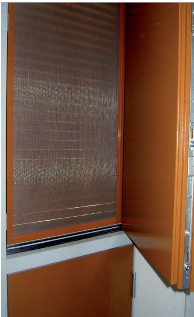
Met een zomernachtventilatie blijft een passiefhuis in de zomer koel.
